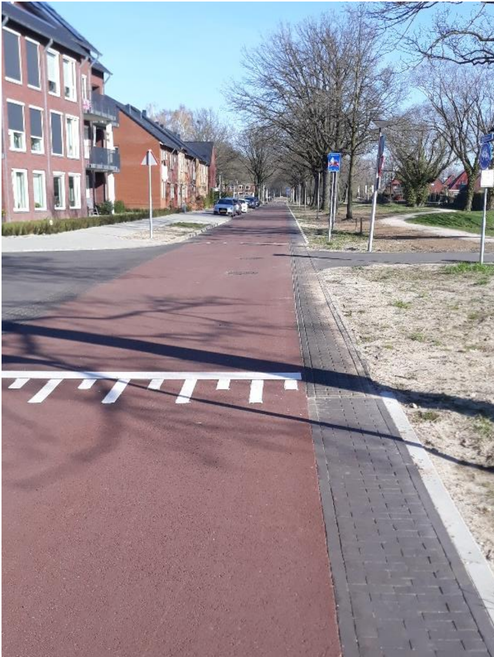
Fietsstraat met rabatstrook in gebakken klinkers op het wegvak en in streetprint bij kruispunt
