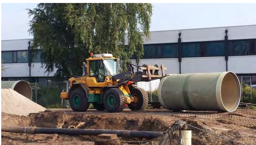
Aanleg riolering Auke Vleerstraat
