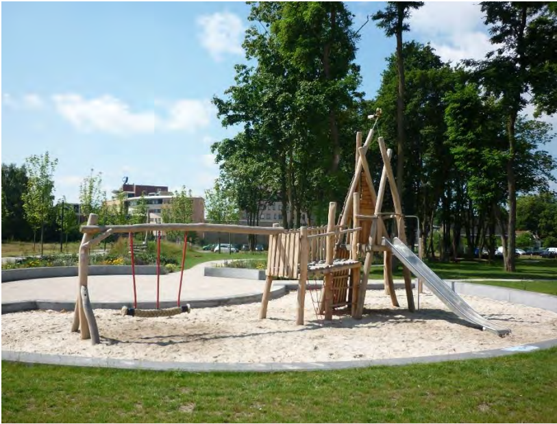
Houten speeltoestel met speelzand opgesloten met betonband
