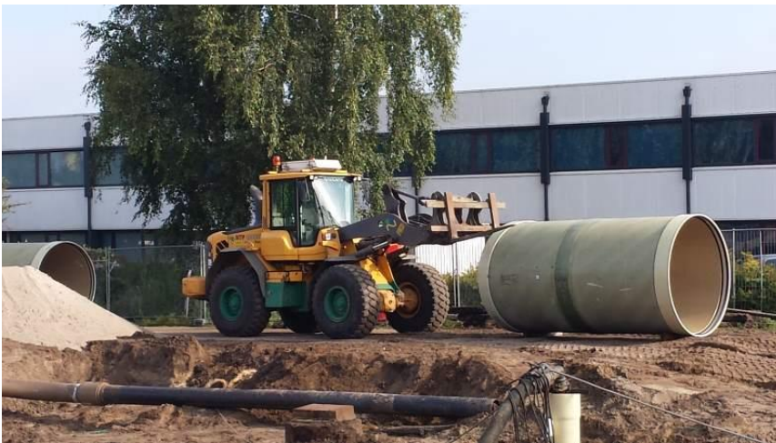
Aanleg riolering Auke Vleerstraat
