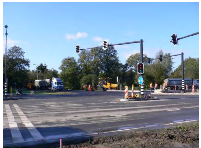
Werkzaamheden bij VRI
