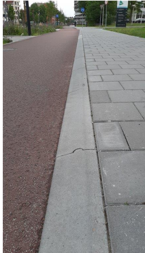
Fietspadband naast trottoir
