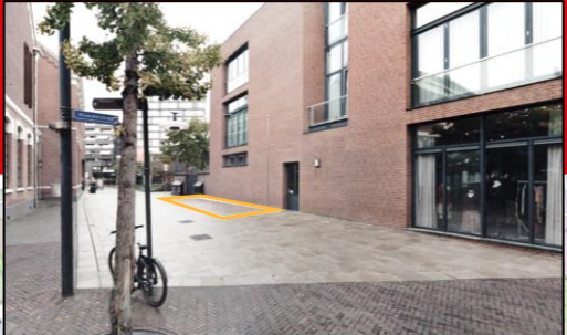
Kloosterstraat, tegen de muur tussen de uitrit (poort) en de grijze deur
